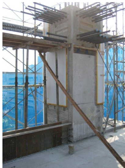
(2)實際梁柱接頭施工圖
