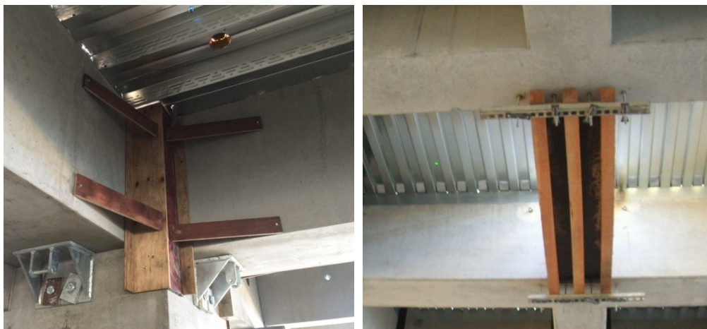
圖 R9.5 預鑄構材與現場澆置混凝土部分之模板例
