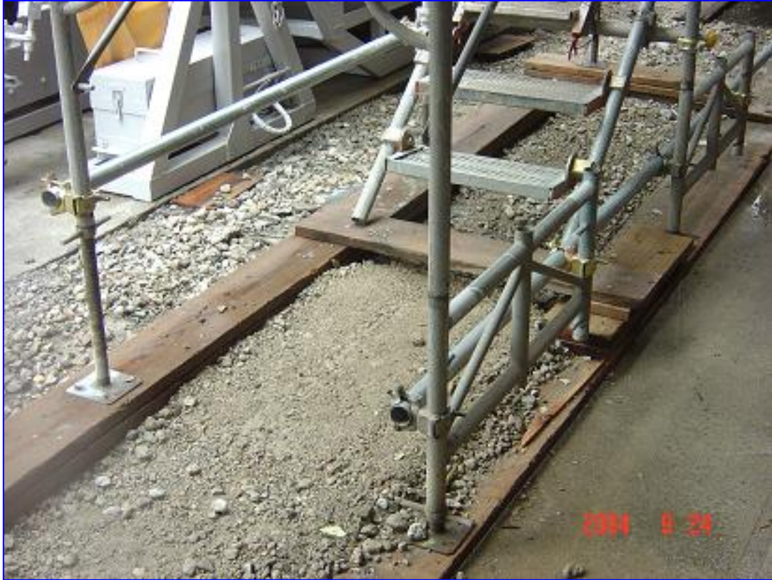
照片 10：施工架底部之立架設可調型基腳座板，基礎地面應平整、夯實緊密、襯以適當材質之墊材，以避免產生不均勻沉陷。
