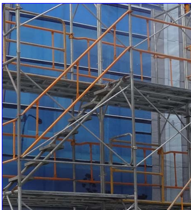
照片 2：上下設備樓梯應有適當護欄（得採足以防護工作者墜落之上端交叉拉桿扣釘固定上拉桿等設備代替）。
