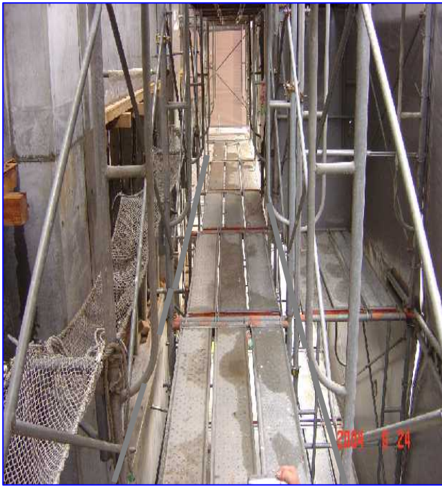
照片 3：工作台鋪滿密接之踏板，施工架踏板間之縫隙小於 3 公分。
